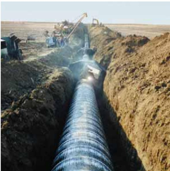
**Bild 6** Schweißen im Rohrleitungsbau mit Zelloseelektroden
