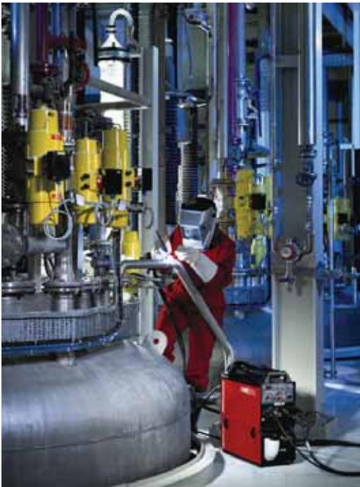
**Bild 30 TRITON 260 DC, WIG-Schweißen an Rohrleitungen**
