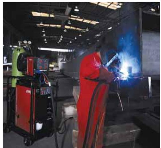
**Bild 38** MAG-Schweißen an Trägern im Stahlbau
