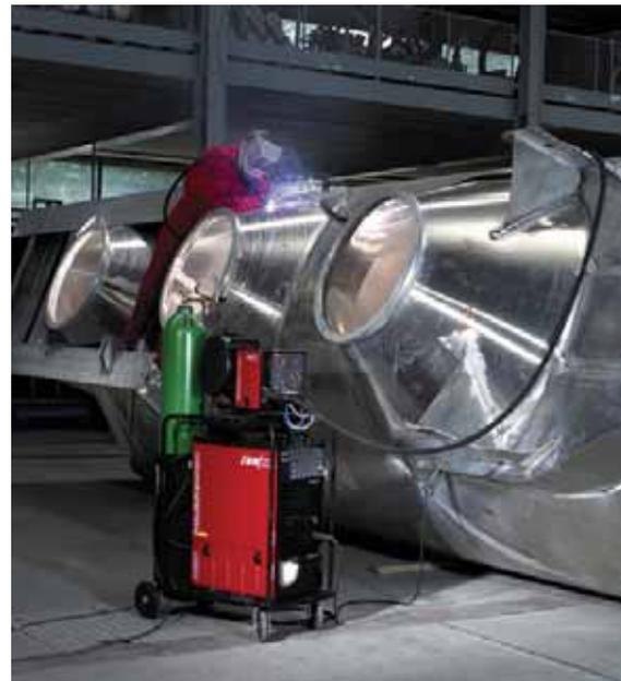
**Bild 39** MIG-Aluminium-Schweißen im Fahrzeugbau
