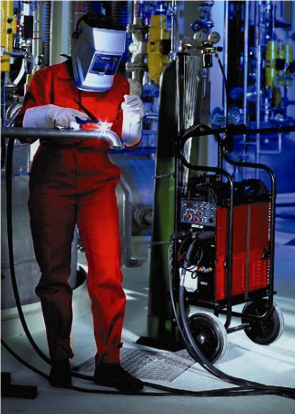
Bild 6 WIG-Schweißerarbeiten in der Chemie-Industrie
