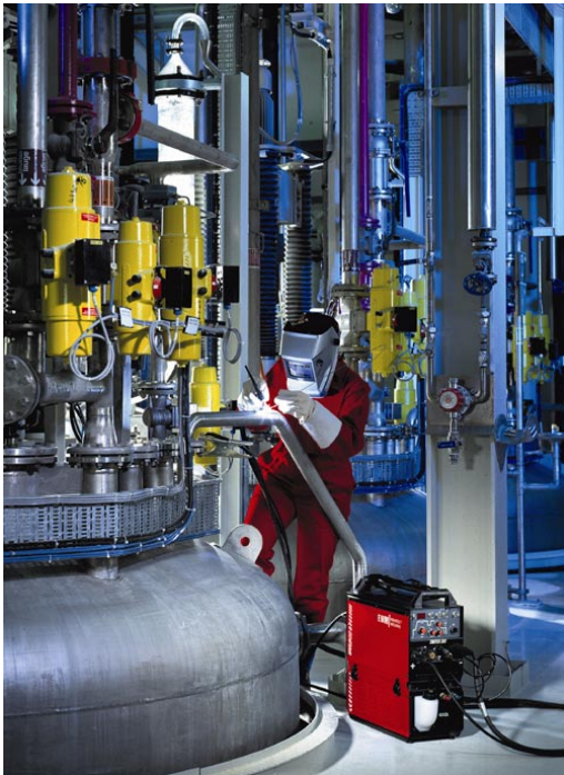
Bild 30 TRITON 260 DC, WIG-Schweißen an Rohrleitungen
