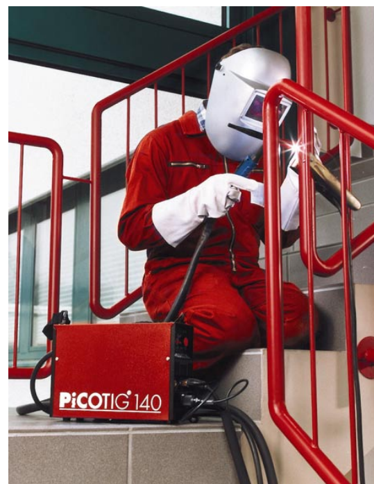
Bild 4 WIG-Schweißen an einem Geländer
